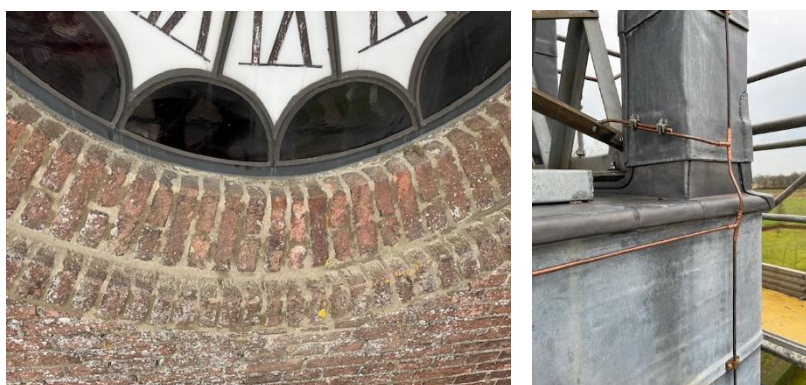
Het gerepareerde metselwerk en de herstelde bliksembeveiliging.
